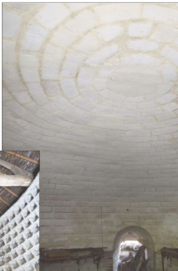
Le pigeonnier de 900 boulines ; la cave voûtée reprend la charge de l'appareillage d'accès aux boulines.
